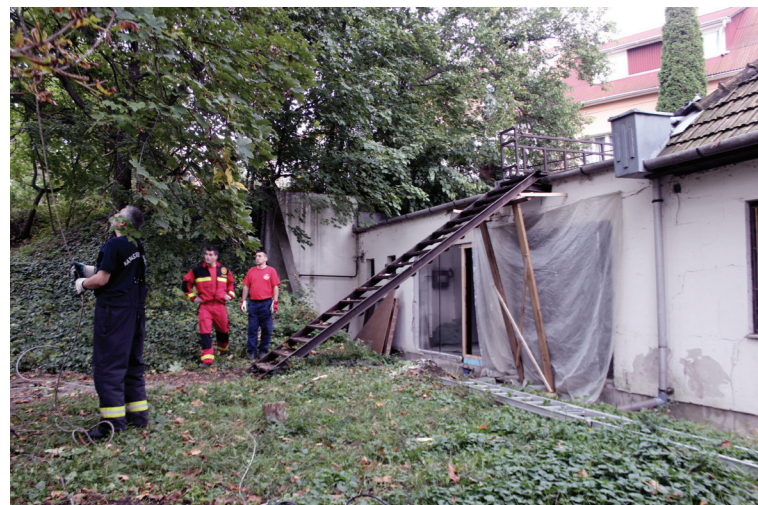
Az udvar felőli rész felújítás közben
