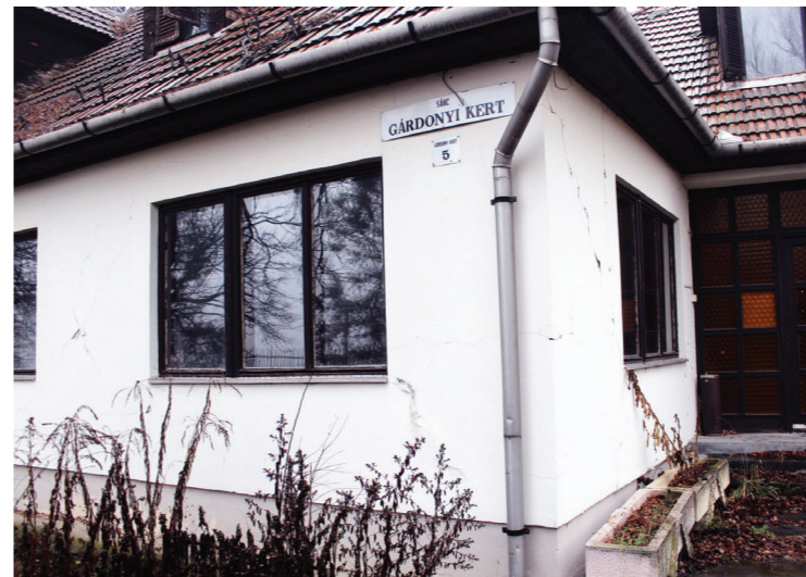
A ház régi homlokzata az utca frontról
