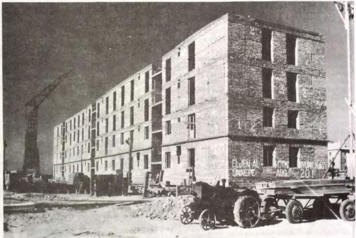
A. f.: 47. Sztálinváros, építkezés.
